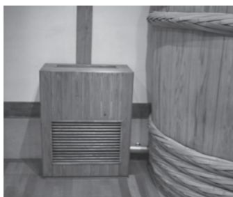
新たに設置した除湿機
