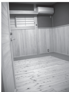
増設した作業室
